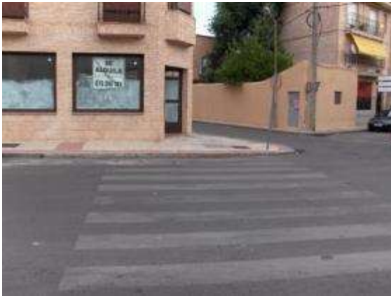
Ilustración 48.- Problemas accesibilidad por falta rebajes en bordillos de pasos de peatones: paradas 33 y 99
