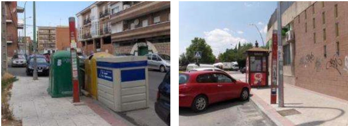
Ilustración 46.- Problemas accesibilidad por presencia mobiliario: paradas 33 y 79
