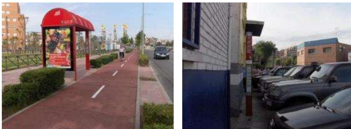
Ilustración 52.- Problemas interferencia espacio de tránsito otros usuarios: paradas 98 y 142
