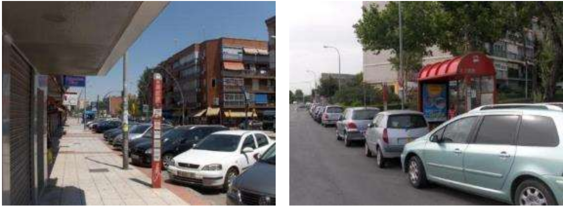
Ilustración 45.- Problemas accesibilidad por estacionamiento: paradas 6 y 35
