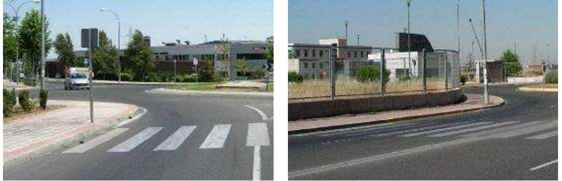
Ilustración 64 Pasos de peatones sin rebaje de bordillos. C/ Constitución y Camino del Molino
