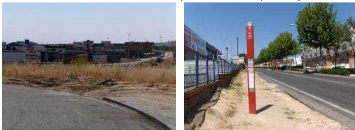
Ilustración 50.- Problemas accesibilidad por ausencia de aceras: paradas 37 y 39
