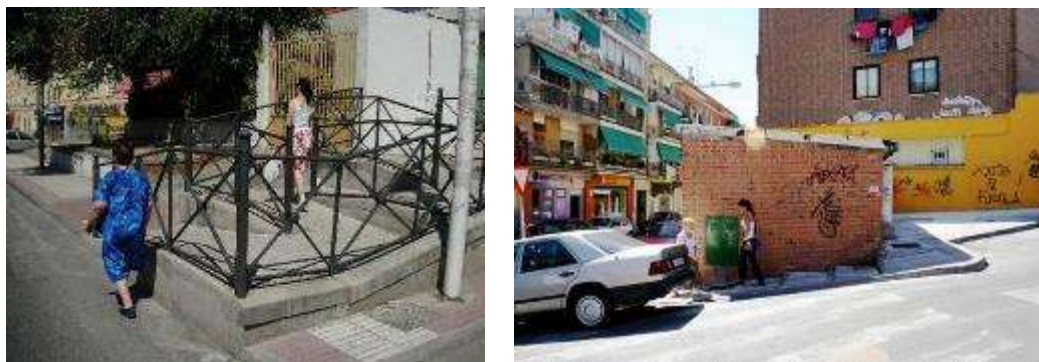
Ilustración 62 Problemas de accesibilidad en aceras del centro urbano. Calles Leganés y Delicias
