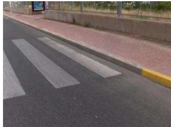
Ilustración 48.- Problemas accesibilidad por falta rebajes en bordillos de pasos de peatones: paradas 33 y 99
